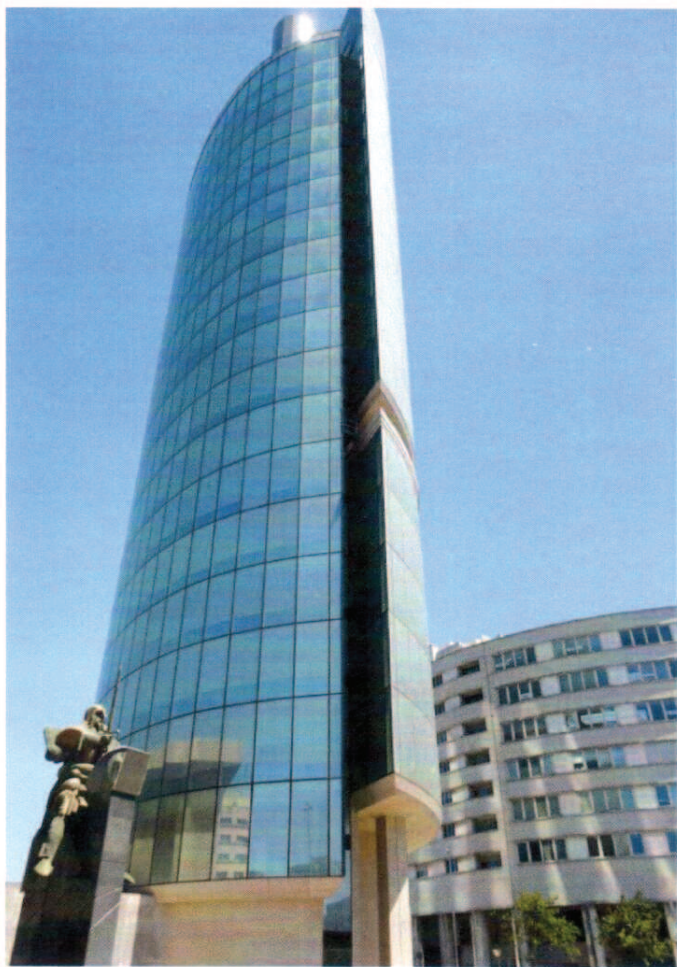
O RCM tem recebido grande apoio da Câmara Municipal da Maia
